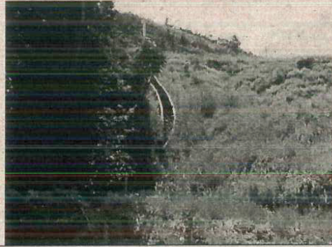
Fotos 1.15 e 1.16. Redimensionar o sistema de drenagem definitivo. Lançamento das águas pluviais em propriedades lindieras, causando assoreamento e inundação (km 34+600)
