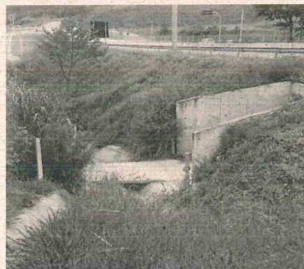
Passarela de concreto que foi implantada na saída do emboque da passagem de fauna.
