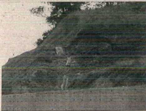
Foto 1.3. Reconstruir o sistema de drenagem definitivo e reafeiçoar e estabilizar os taludes (Km 20+900).
