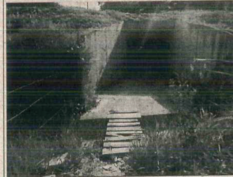
Foto 3.12. Adequar entrada da passagem de fauna situada no km 49+350 (implantar passarela de concreto). Vão formado por sistema de drenagem dificulta ou não permite a entrada de animais. A ponte de madeira é uma medida temporária.
