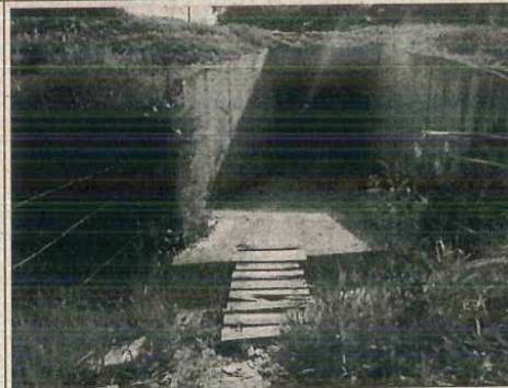
Foto 3.12. Adequar entrada da passagem de fauna situada no km 49+350 (implantar passarela de concreto). Vão formado por sistema de drenagem dificulta ou não permite a entrada de animais. A ponte de madeira é uma medida temporária.
