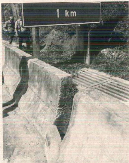
Trecho do guarda corpo localizado na extremidade sul da OAE, cuja drenagem está fechada, impedindo o lançamento direto no curso d'água.
