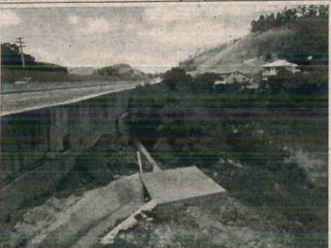
Foto 1.17. Readequar o sistema de drenagem pluvial, redirecionando o fluxo para a caixa de produtos perigosos. Lançamento parcial das águas no corpo d'água (Rio Paraíba) a poucos metros da captação pública do município de Paraíba (Km 35+300)
