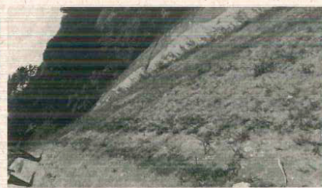
e Hidrossemeadura começando a germinar
