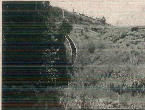
Fotos 1.15 e 1.16. Redimensionar o sistema de drenagem definitivo. Lançamento das águas pluviais em propriedades lindeiras, causando assoreamento e inundação (km 34+600)
