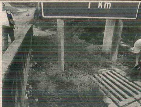
Foto 1.2. Readequar o sistema de contenção de produtos perigosos. Lançamento das águas pluviais diretamente no corpo água. Proteção parcial do trecho. (Km 18)
