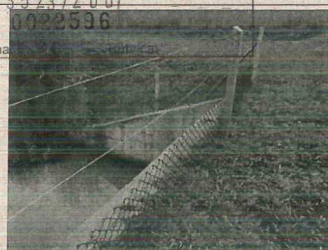
Foto 3.2. Adequar as cercas de direcionamento de fauna junto ao emboque da passagem de fauna inferior no km 14+300, de acordo com a Norma DNIT 077/2006 (recomendação de tela com 2 metros de altura, entre outros).
