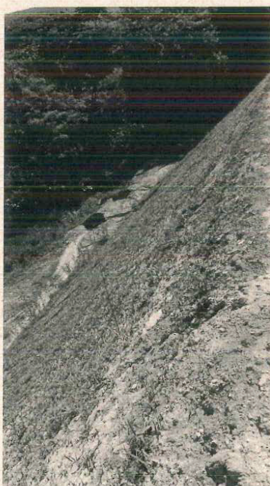
Hidrossemeadura implantada em todo o talude
