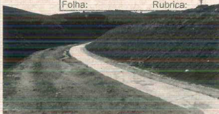
Conclusão das canaletas da drenagem definitiva da bermã
