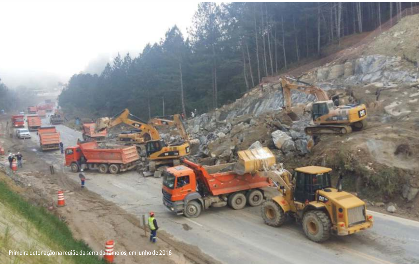
Em dezembro de 2015, movimentação inicial na região do Canteiro Central
