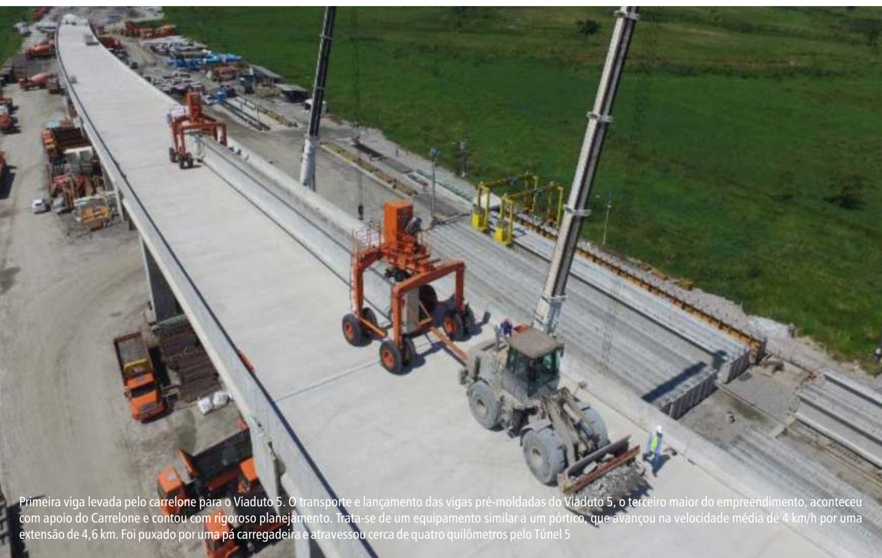
Viaduto 5, em março de 2019
