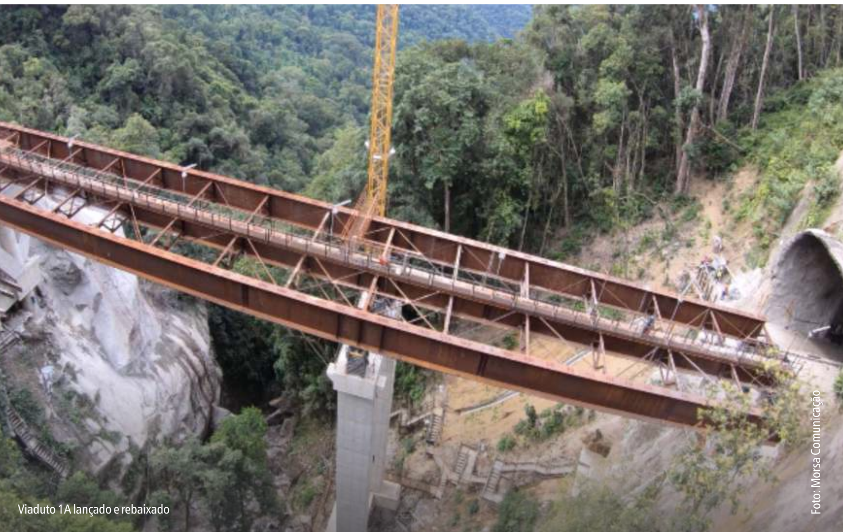
Empurramento do V1A de dentro do Túnel 2. O sistema usou conjunto de macacos hidráulicos com capacidade de carga de 100t
