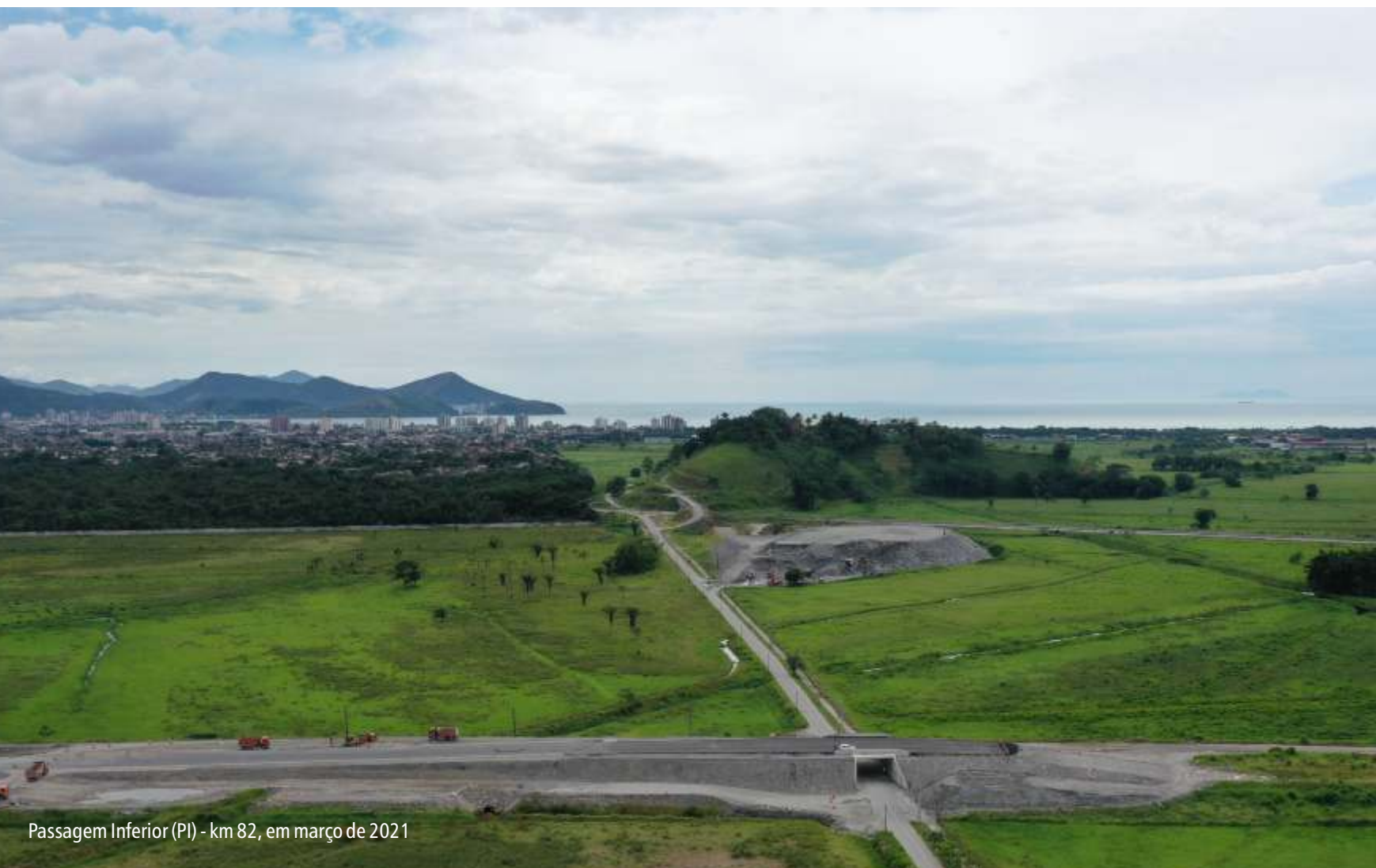
Viaduto 10, em fevereiro de 2022
