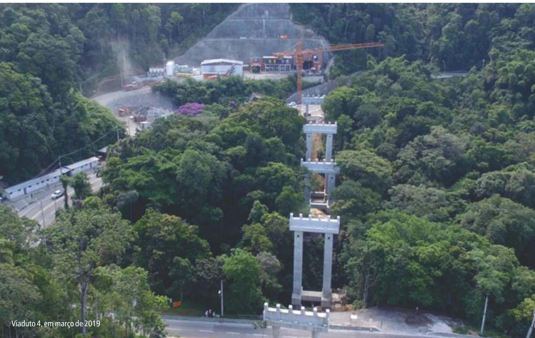
Vista dos Viadutos 5 e 4
