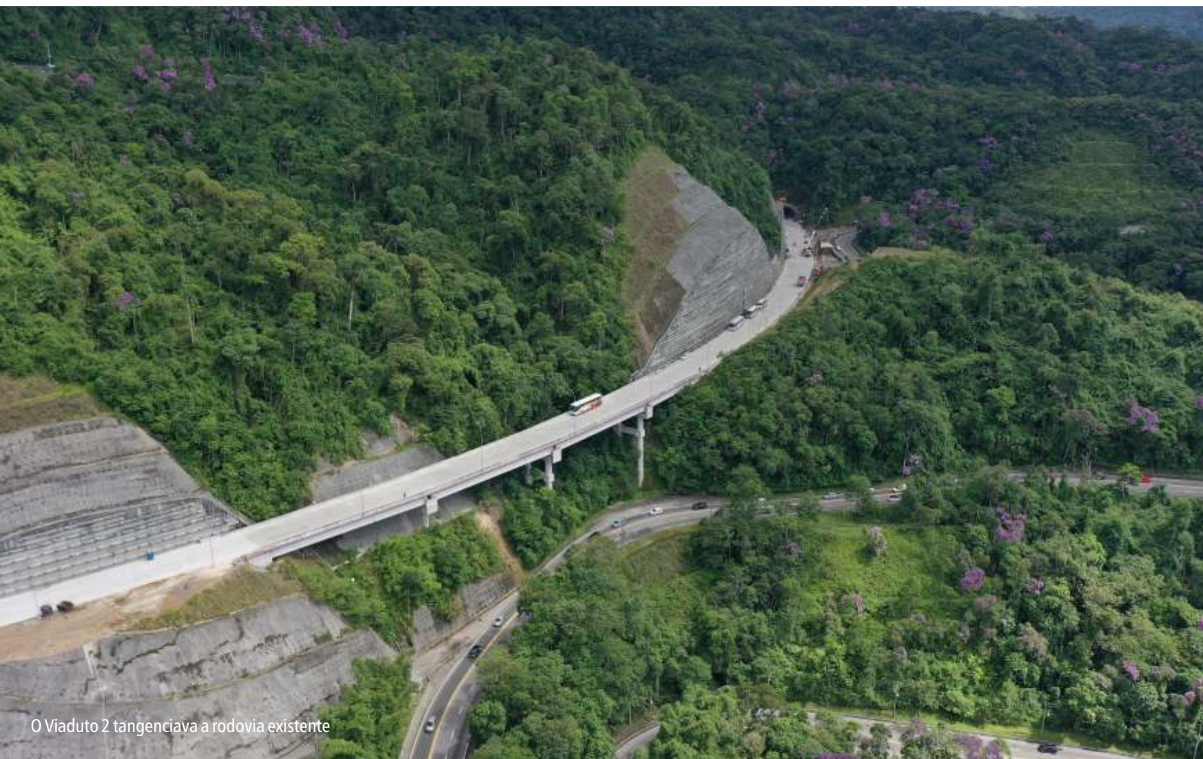
Viaduto 2, em março de 2019
