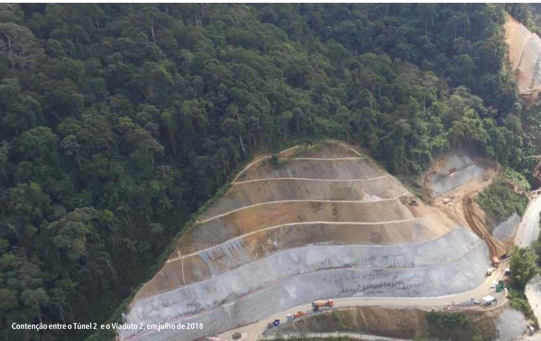
Contenção entre o Túnel 2 e o Viaduto 2, em março de 2018
